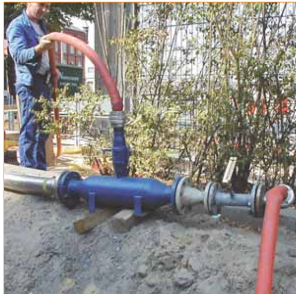
Bild 5. Beimischung von Kaltwasser über einen Mischkühler
