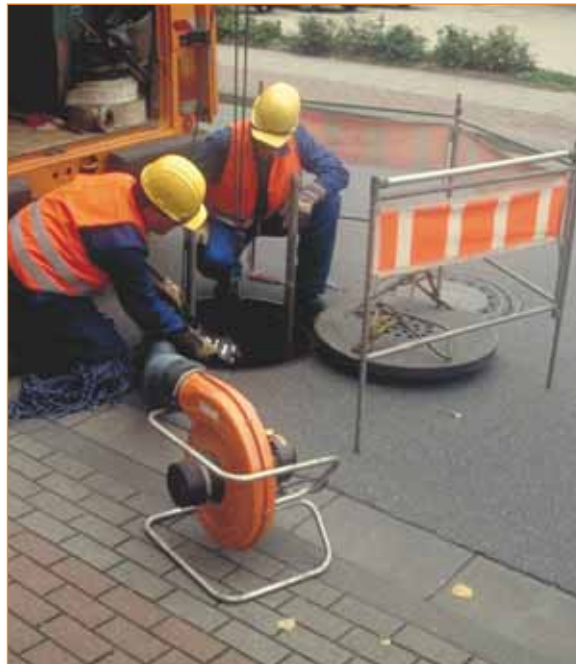
Bild 2. Sicherung des Schachteinstiegs
