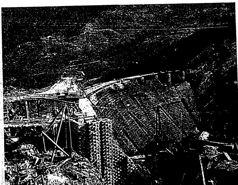
← Construcción de la parte superior de la presa. En primer término, el doble pozo para cierre de la junta.
