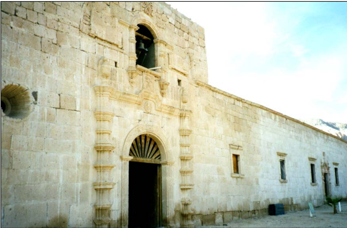
El pórtico de San Borja se debe a los franciscanos, y la obra de cantera a los dominicos
