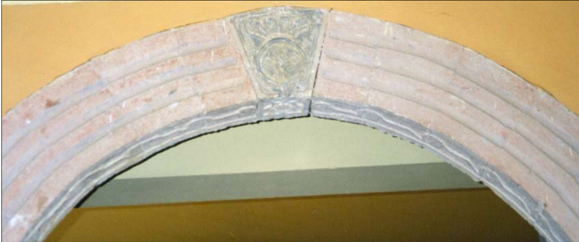
Arco original de cantera adosado a una trabe de concreto en la iglesia de Todos Santos
