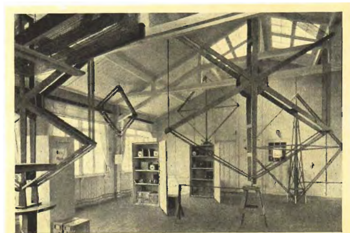
Bild 171. Transradio-Empfangsanlage Geltow 1923. Rahmen-Empfangseinrichtungen für die Aufnahme europäischer Gegenstationen.
