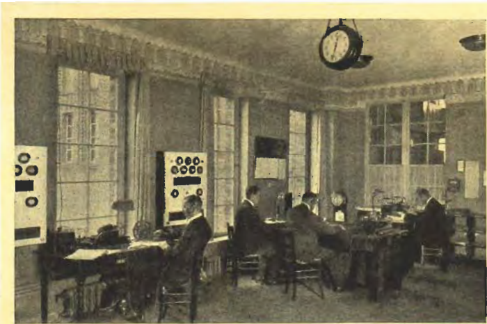
Bild 163. Nauen vor den Zeiten der Transradio-Betriebszentrale (1919): Telegraphierraum im Großstationsbetriebsgebäude. Die Sender wurden von hier aus getastet, die Telegramme von Berlin aus über eine Hughes-Leitung zugebracht. (Vergleiche Bild 167 und Seite 201).
