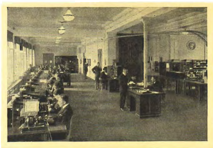
Bild 175. Ansicht der Berliner Transradio-Betriebszentrale 1925. Moderne Sende- und Empfangstische im großen Betriebsraum. Einzelheiten siehe Bild 177 und Bild 178. In der Mitte des Raumes der Funkleiter, ganz hinten der Zentralschaltplatz, einschließlich Klinkenschrank, Verstärker- und Gleichrichteranlagen.
