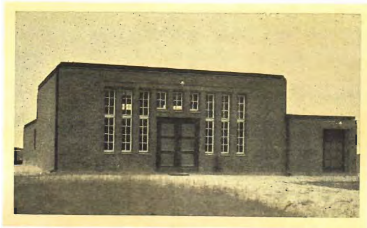
Bild 180. Neues Kurzwellen-Senderhaus I der Station Nauen, Bauentwurf von Geheimrat H. Muthesius. Enthält heute zwei Sender von je 20 Kilowatt für Übersee- und Weitverkehr.
