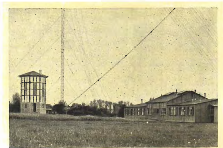
Bild 170. Transradio-Empfangsanlage Geltow mit dem Empfangsturm 1923. Dieser enthielt eine drehbare Rahmenantenne von 16 Quadratmeter Fläche und in einem gepanzerten Raume das damit gekoppelte Empfangsgerät nebst Batterien. Inneres der rechts sichtbaren Baracke siehe nächstes Bild.
