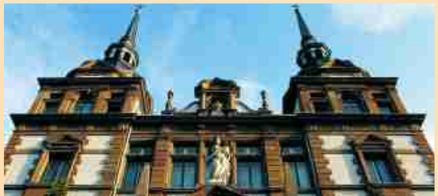
Der „Alte Marienbau“ war 1890 das Hauptgebäude des Krankenhauses. Heute ist er Sitz der Klinikverwaltung
