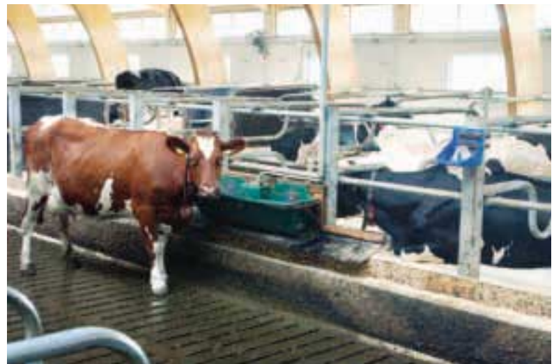
■ Lehmien kulkureiteillä on ritilät, joiden alla ja päällä on raapat. Kuminen yläraappa pyyhkii liemet ritilän rakoihin, jotta lehmien jalat pysyvät puhtaampina.
