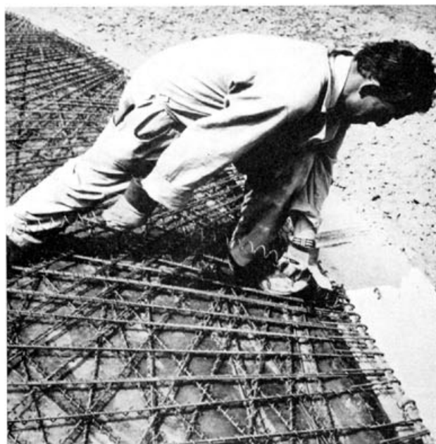
Fig. 3. Posa armatura a spirale
