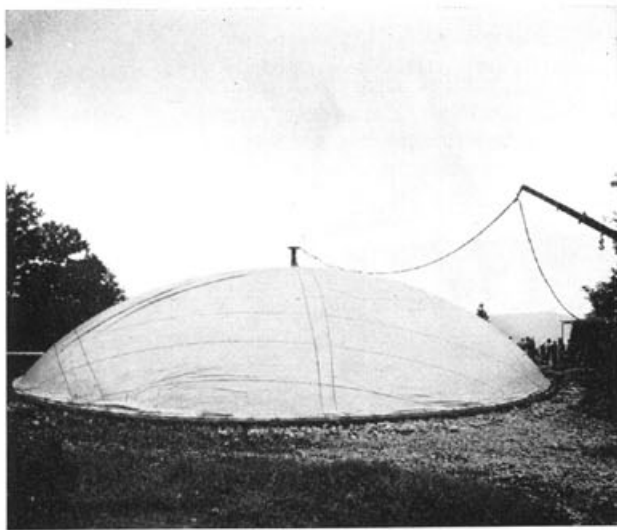
Fig. 7. Fase di gonfiaggio - metà sollevamento
