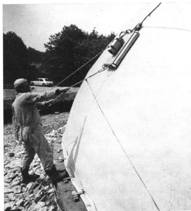
Fig. 9. Vibrazione della struttura a sollevamento ultimato
