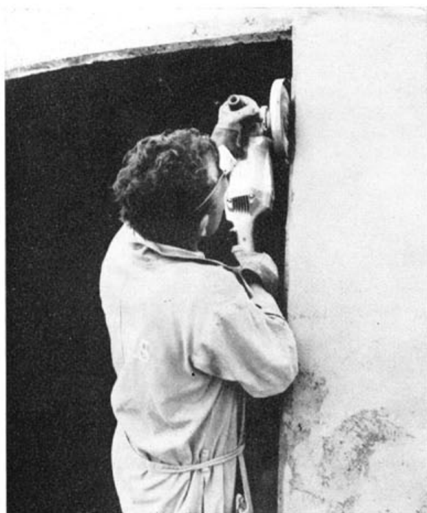
Fig. 10. Taglio delle aperture con flessibile
