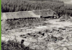
Erste Gründungsarbeiten an Fundamenten und Scheibenbahn
