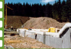
Sanierung und Erweiterung der Scheibenbahn
