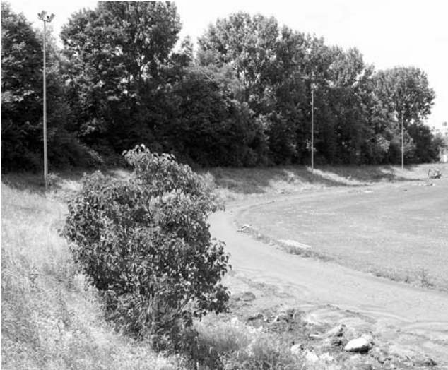
Vor Beginn der Bauarbeiten. Blick zur Böschung der Kleingartenanlage, im Hintergrund die Häuser Struthbachweg. Zu sehen ist auch noch ein Teil der 400 m Laufbahn sowie des Rasenspielplatzes.
