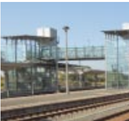
Fuß- und Radwegbrücke mit Aufzugstürmen
