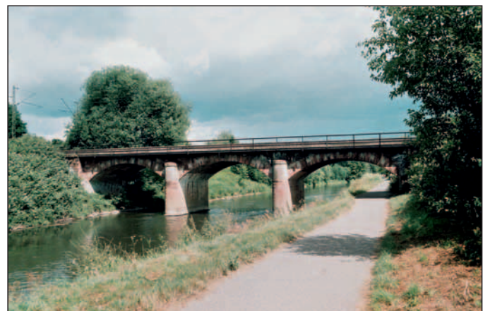
Abb. 6: Technisches Denkmal: Die Niddabrücke der Taunus-Eisenbahn in Frankfurt-Nied
