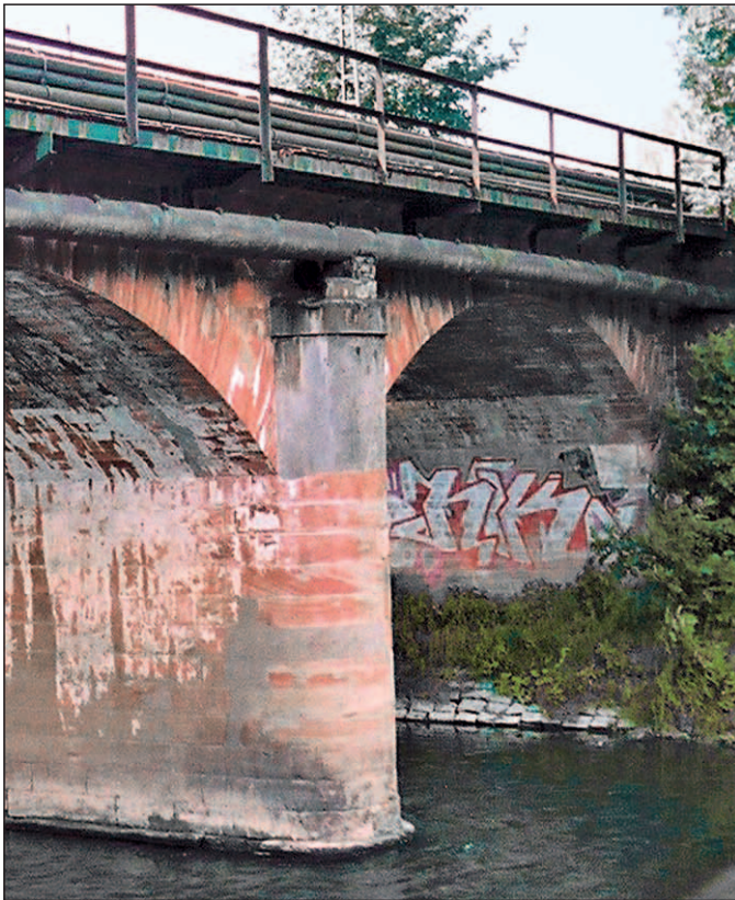
Abb. 10: Erheblicher Schaden durch Bewuchs an der Flügelmauer des Dammschlusses der Niddabrücke in Richtung Frankfurt-Höchst
