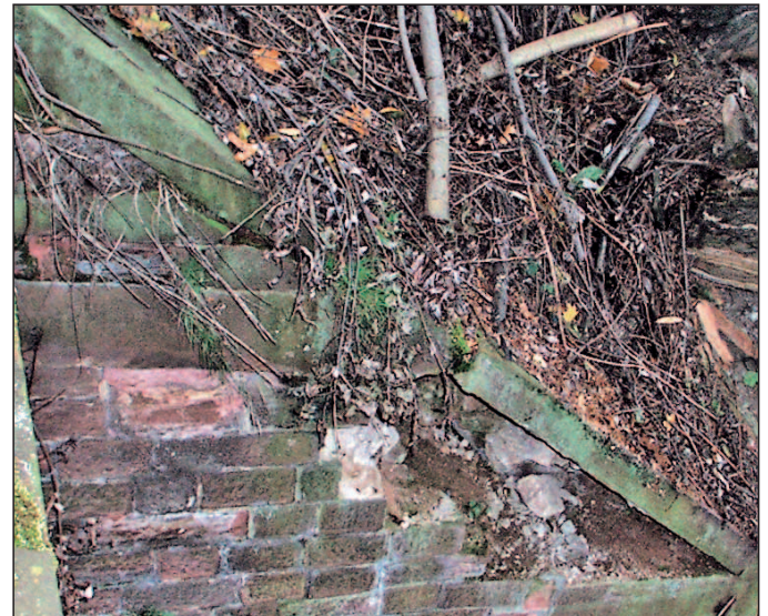
Abb. 10: Erheblicher Schaden durch Bewuchs an der Flügelmauer des Dammschlusses der Niddabrücke in Richtung Frankfurt-Höchst
