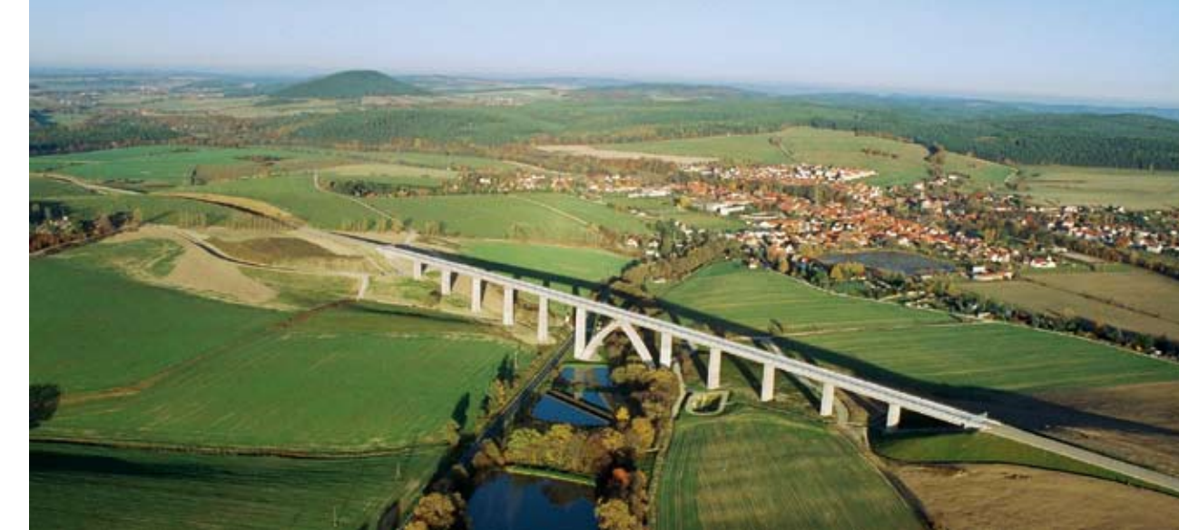
Wümbachtalbrücke in Thüringen, 42 m hohe Stahlbetonkonstruktion, der A-Bock überspannt auf 76 m Länge den Wümbach
