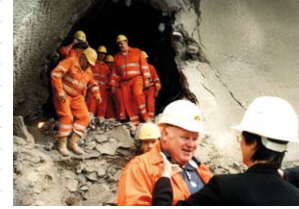
Tunneldurchschlag Augustaburgtunnel am 26. August 2004
