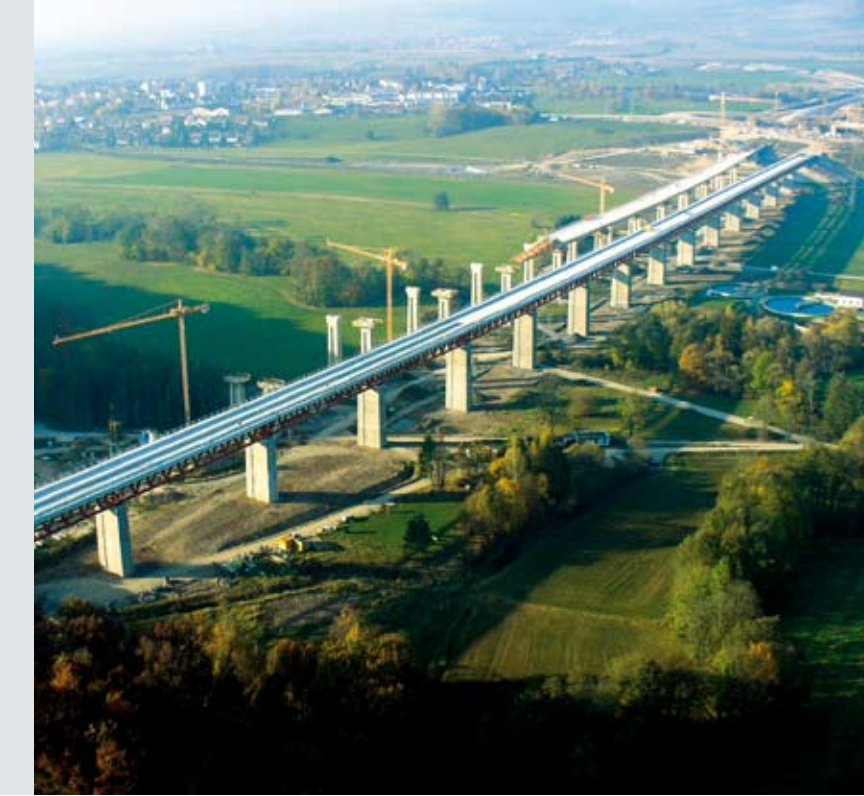
Itztalbrücke bei Rödental in Bayern, Stahl-Verbund-Tragwerk mit oben liegender Betonfahrbahnplatte (parallel im Hintergrund die BAB A73)
