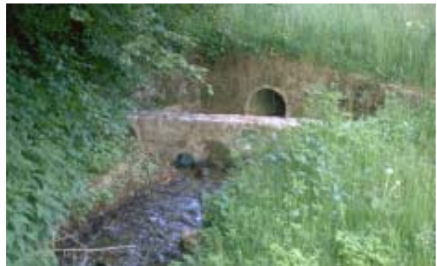
Eindolung des Seitenbaches beim oberen Chasten (Blick von oben in den Sandfang).
