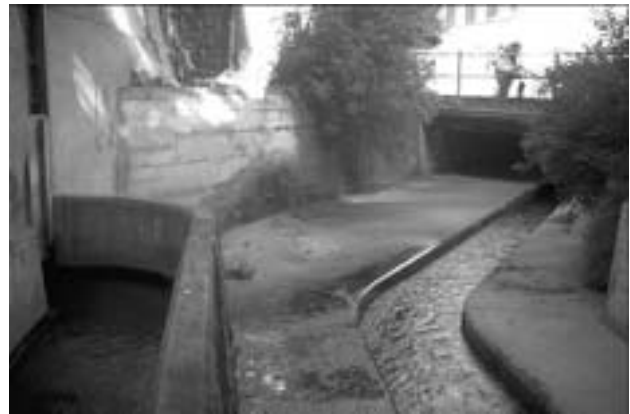
Überdeckung Wynigen von oben gesehen.
