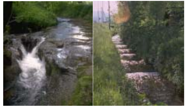
Die Einengung des Gerinnes führt zur Tiefenerosion bis auf die Molassefelsen (Bild links) und wird kompensiert durch viele kleine Schwellen. Diese führen zu einem monotonen treppenförmigen Bachlauf (Bild rechts).
