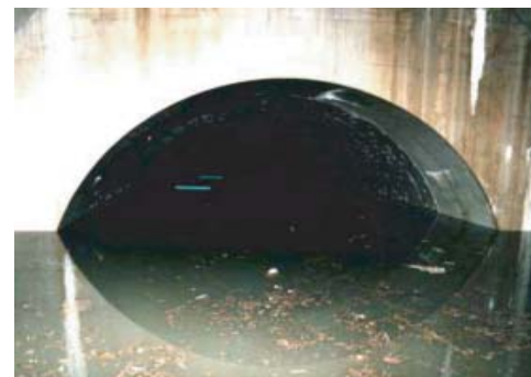
■平野川調節池における貯留状況
