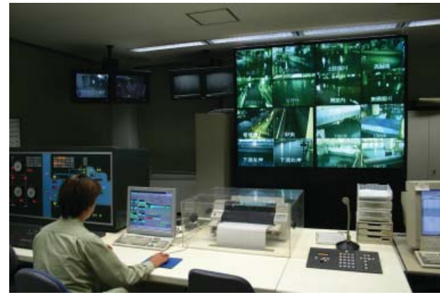
道頓堀川水門操作室
