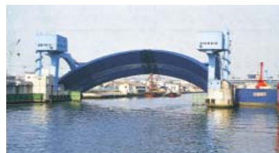
●閉鎖中(尻無川水門)
