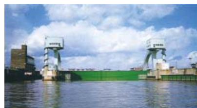
●閉鎖完了(木津川水門)
