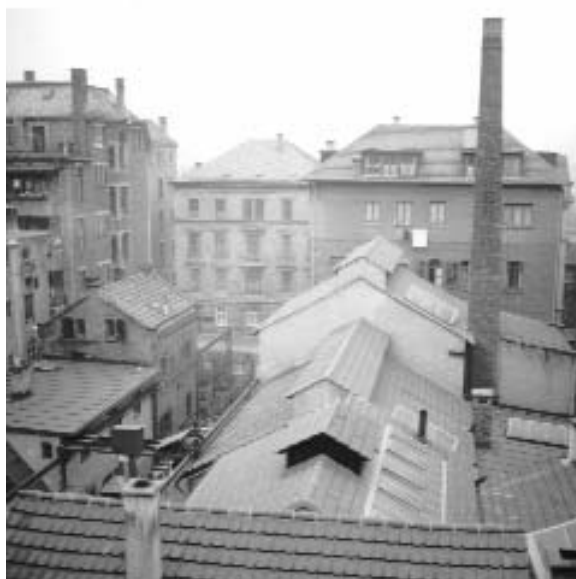
Bild 37: Die nach dem Zweiten Weltkrieg wieder aufgebaute Glockengießerei
