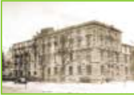
Schwer beschädigt: Dresdner Bank in der Gallusanlage 7
