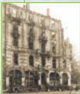
Auswirkungen des Bombenkrieges: Depositenkasse A der Dresdner Bank in Frankfurt am Main, Kaiserstraße 32 1945
