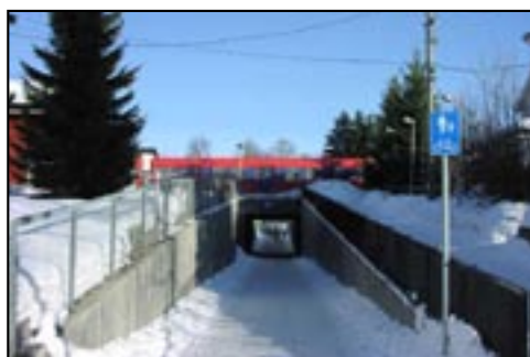
T-baneundergang syd for Ekraveien.
