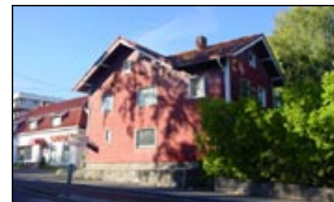
5b. Griniveien 1, (trehusbebyggelsen i dag).
