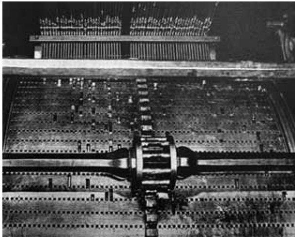
Afb. 1. Detail trommelspelwerk op het Kon. Paleis te Amsterdam (Spraeckel, 1664). De afmetingen van deze trommel komen sterk overeen met die van de trommel op de St. Catharinakerk te Danzig:
