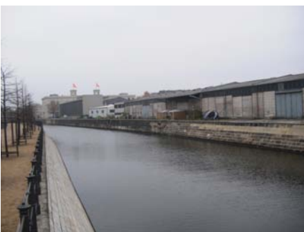
Lagerhallen östlich der Heidestraße
