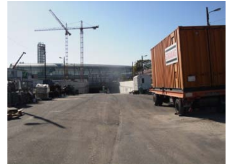
Tunnelmund der B 96 im Bau
