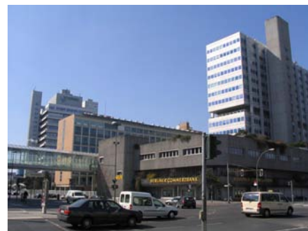
Schering AG in der Müllerstraße/Ecke Sellerstraße
