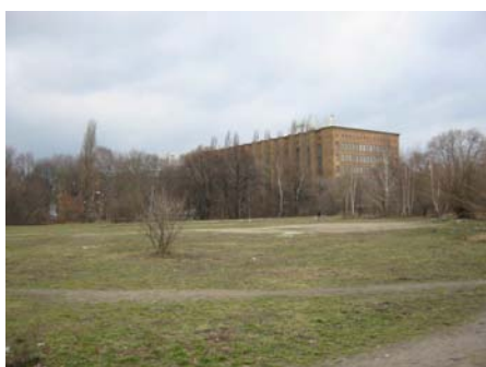
Grünfläche vor dem Bewag-Umspannwerk
