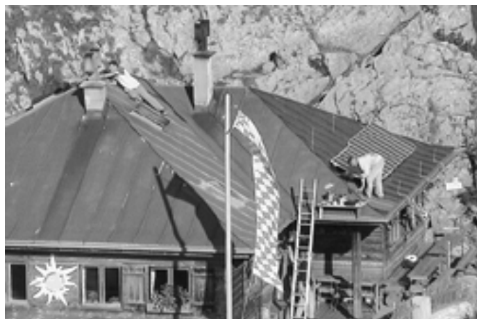
Das Dachstreichen gehört u. a. zu den Aufgaben des Hüttenwirts.
