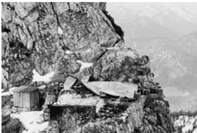
Ein Blitzschlag, im Mai 1965, zerstörte die Tegernseer Hütte völlig.
