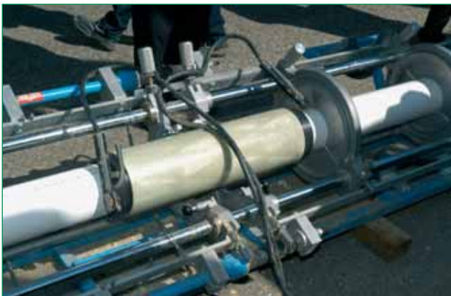
Bild 1: Kombinierte Elektro- und Stumpf-Schweißmaschine zur Herstellung der Verbindung
