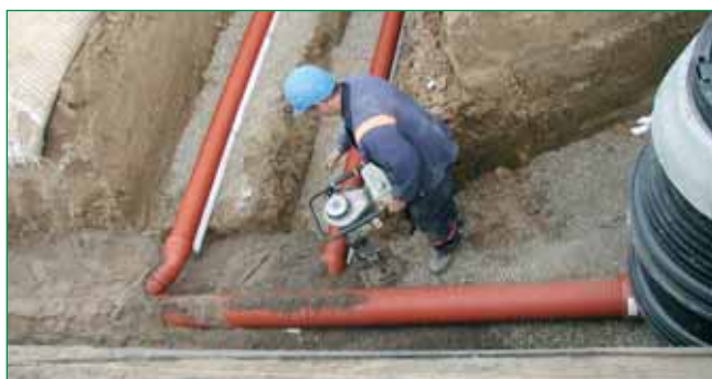
Bild 8: Rohrgraben mit auf Bettungskissen verlegten Rohren (Rödinghausen)
