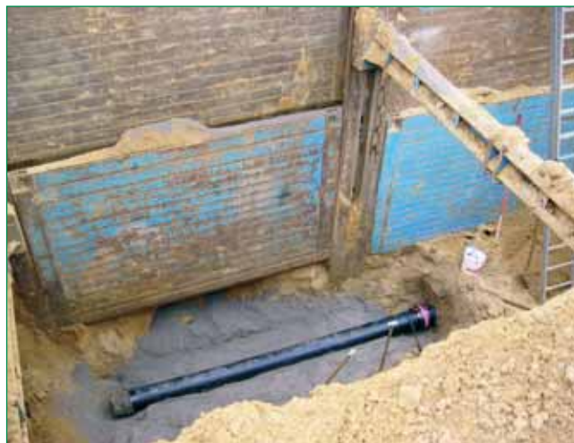
Bild 2: Neue Freigefälleleitung in 6 m Tiefe
