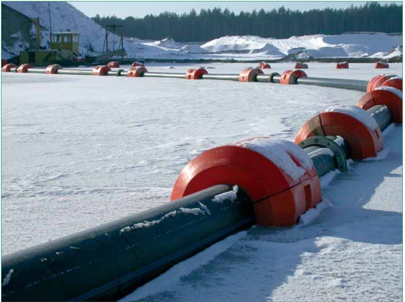
Bild 1: Mit Schwimmern ausgestattete PE-100-Rohre auf feuchtem Grund im Kieswerk Zwirownia Siemiatycze
