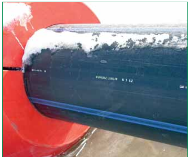
Bild 2: Detailansicht Rohr mit Schwimmer
