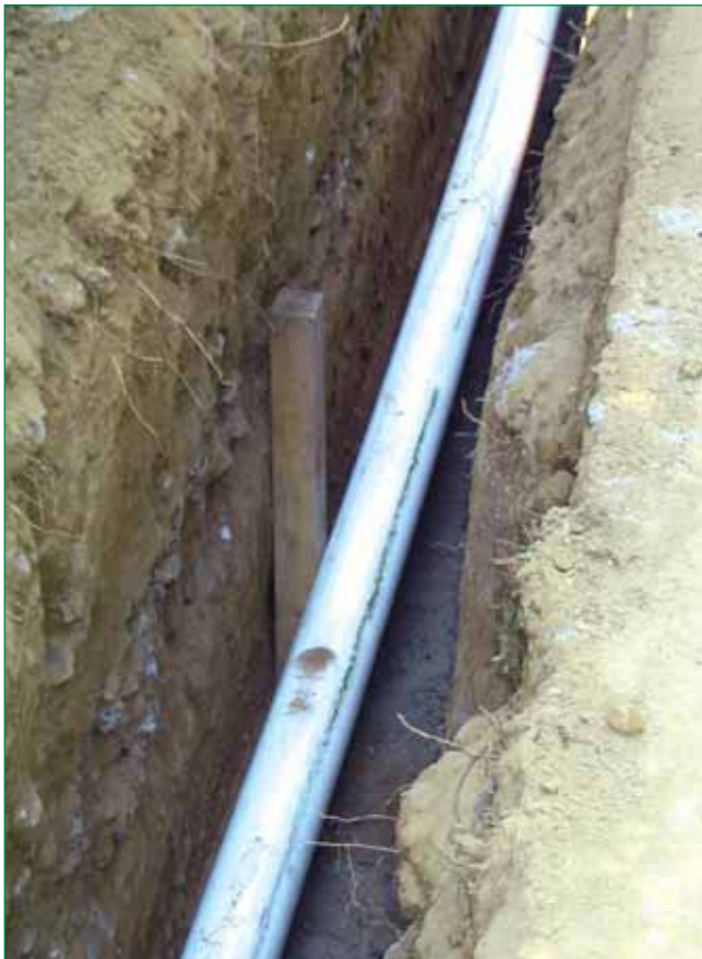
Bild 3: Einbringen des Rohres in gefrästen Graben – Auflegen auf Sandbettung
