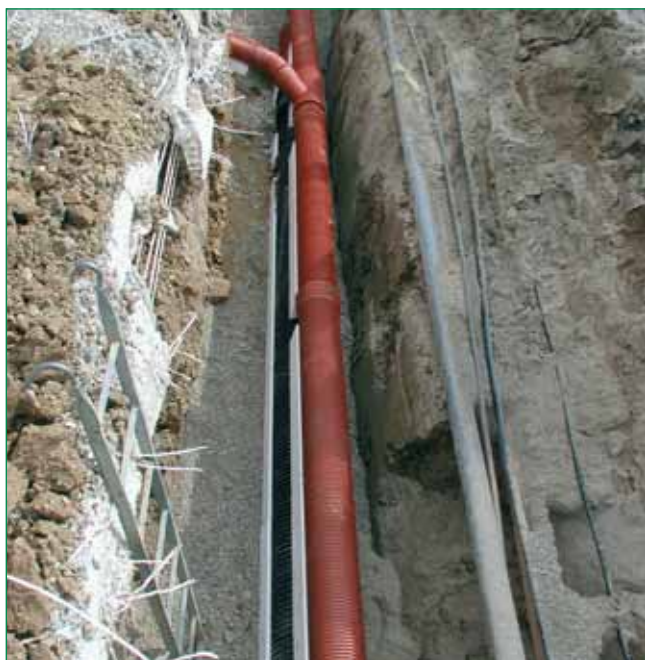
Bild 7: Huckepack verlegte Rohre in schmalen Rohrgraben (Rödinghausen)
