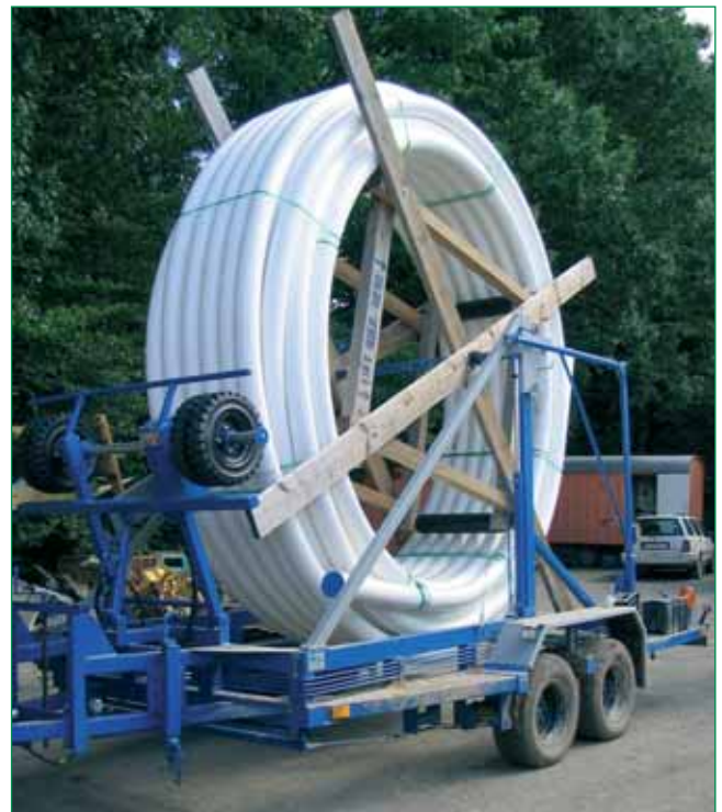
Bild 2: Trommel (280 m) des verwendeten Kunststoffrohres auf Transportwagen
