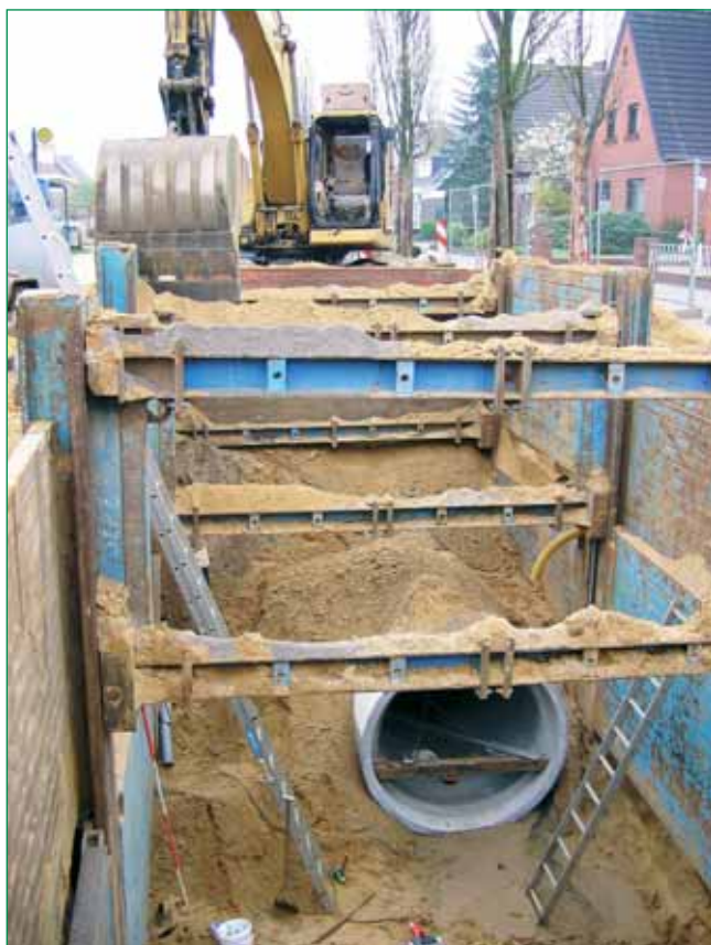
Bild 5: Herausforderung für das Tiefbauunternehmen: extreme Verlegetiefen in sandigen Böden
