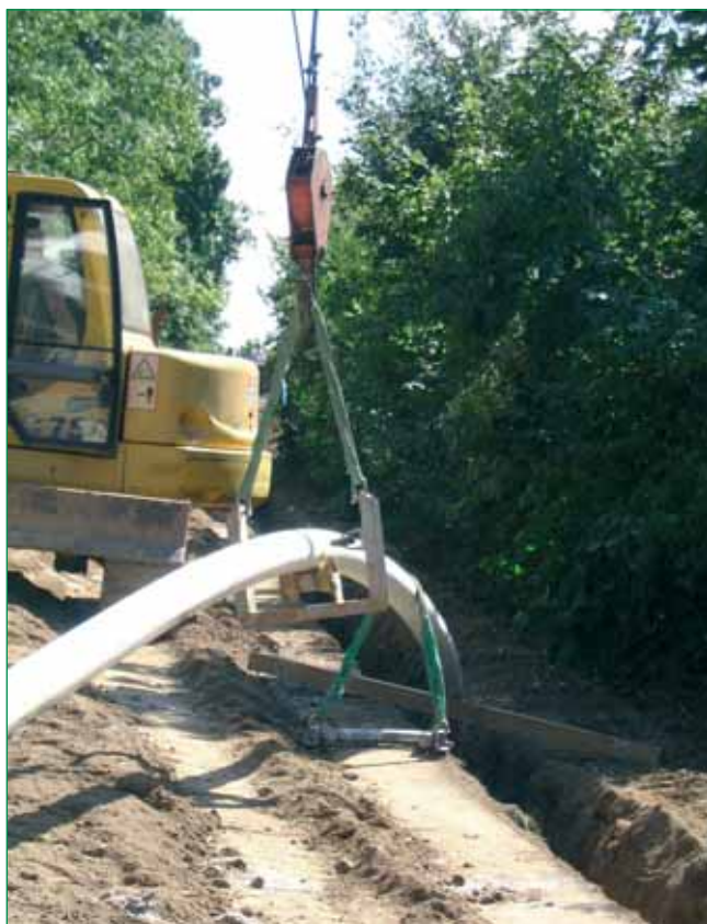
Bild 4: Einbringen des Rohres in gefrästen Graben – Ausnutzen der Flexibilität
