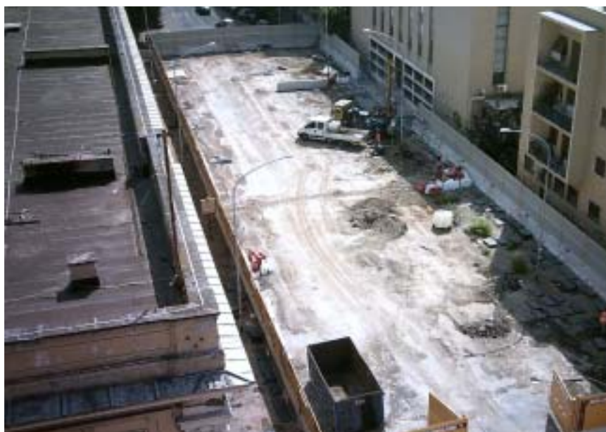
San Giovanni è in corso lo spostamento della condotta fognaria a servizio della scuola Carducci e si sta realizzando il nuovo ingresso alla scuola su viale Castrense
