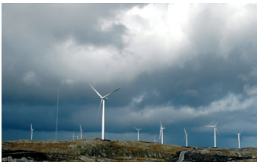
Hitra vindpark i Sør-Trøndelag.
