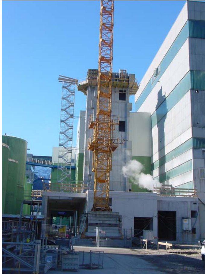
Abb. 8: Errichtung der neuen Verdampferanlage der Salinen Austria AG
