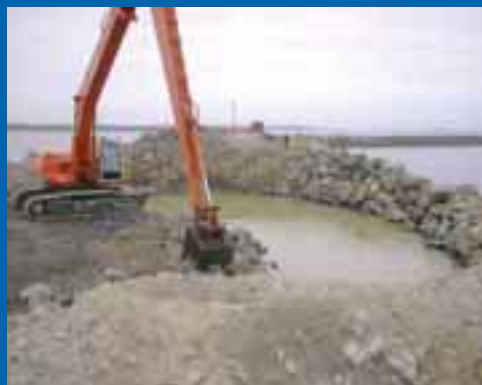
Tuulivoimalan perustuksen massanvaihtoa Kuva: Pekka Ottavainen
