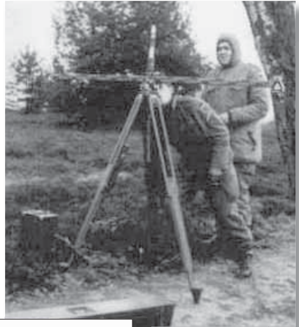
Streckenmessung mit 2 m Basislatte
