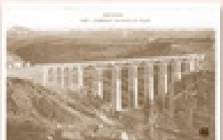
9• Le pont de Toupin est terminé.
