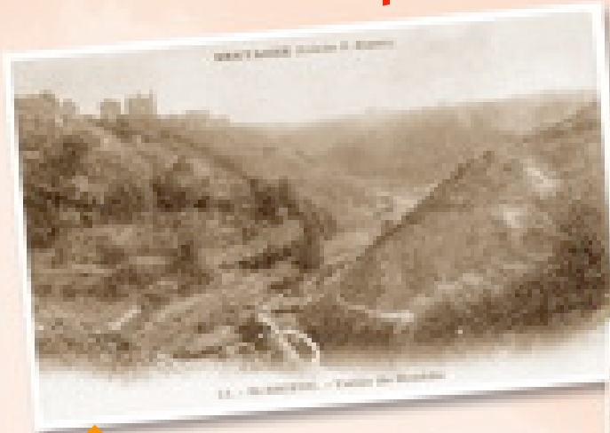
1• La vallée de Gouédic avant les travaux (vers 1900).
