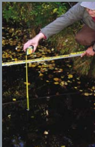
Kestävän padon rakentamisen eri vaiheita. Teroitetut paalut ja sammalmatot on tehty ensimmäiseksi. Latalla ja mittanauhalla mitataan tavoiteltu veden korkeus. Paalut upotetaan lekalla riittävän syvälle. Jotta pato olisi tiivis – vuorataan se suodatinmatalla, jonka päälle turvematot asetetaan.
