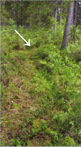
Ennen kunnostusta ojavedet pääsivät sekoittuman lähdenoron veteen. nuoli osoittaa patoa, alapuolinen ojauma on kasvanut umpeen hyvin nopeasti.
