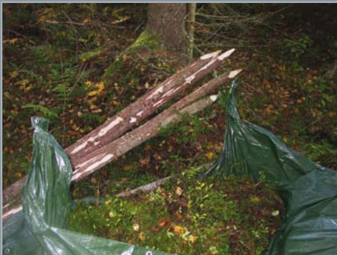
Kestävän padon rakentamisen eri vaiheita. Teroitetut paalut ja sammalmatot on tehty ensimmäiseksi. Latalla ja mittanauhalla mitataan tavoiteltu veden korkeus. Paalut upotetaan lekalla riittävän syvälle. Jotta pato olisi tiivis – vuorataan se suodatinmatalla, jonka päälle turvematot asetetaan.
