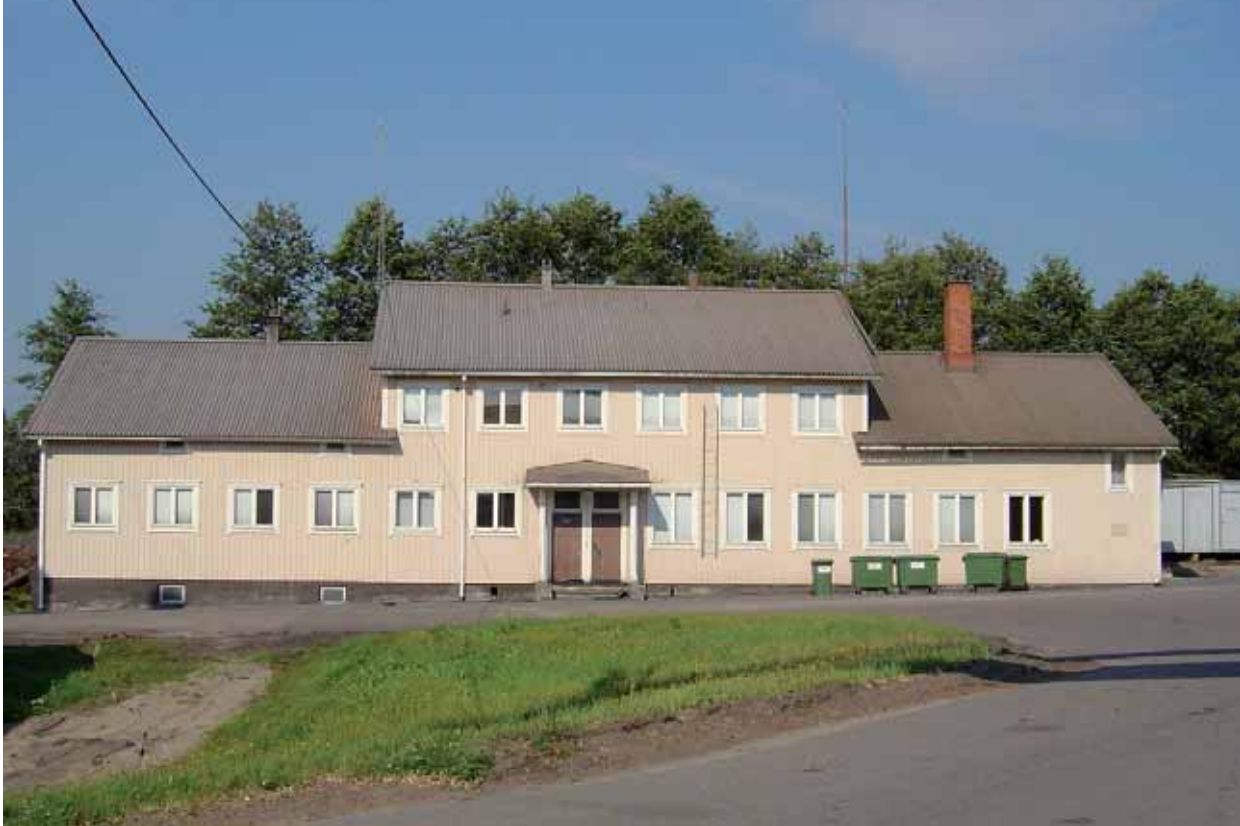
Vanha konttorirakennus vuonna 2005. Rakennus purettiin keväällä 2006.
