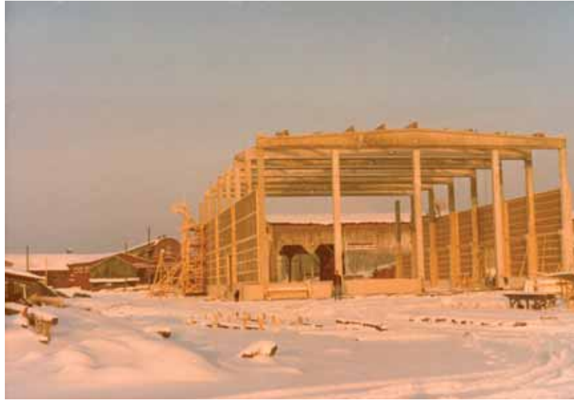
Uuden sahan rakennustyömaa vuonna 1978.
