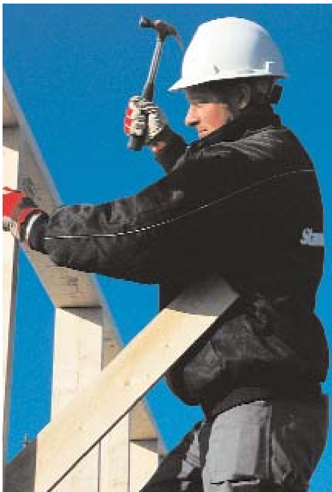
Byggearbeidene pågår for fullt i Vistestølen 4.
