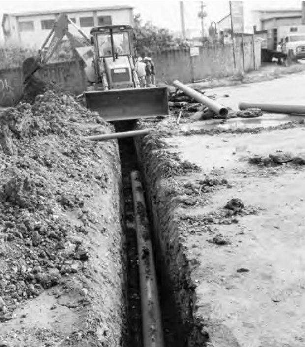
Laying pipes in Guarulhos
