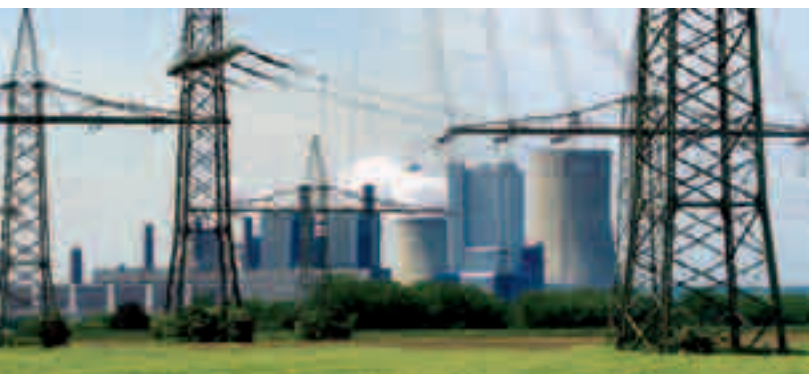
Optimierte Anlagentechnik: Das RWE-Kraftwerk Niederaußem bei Köln.
