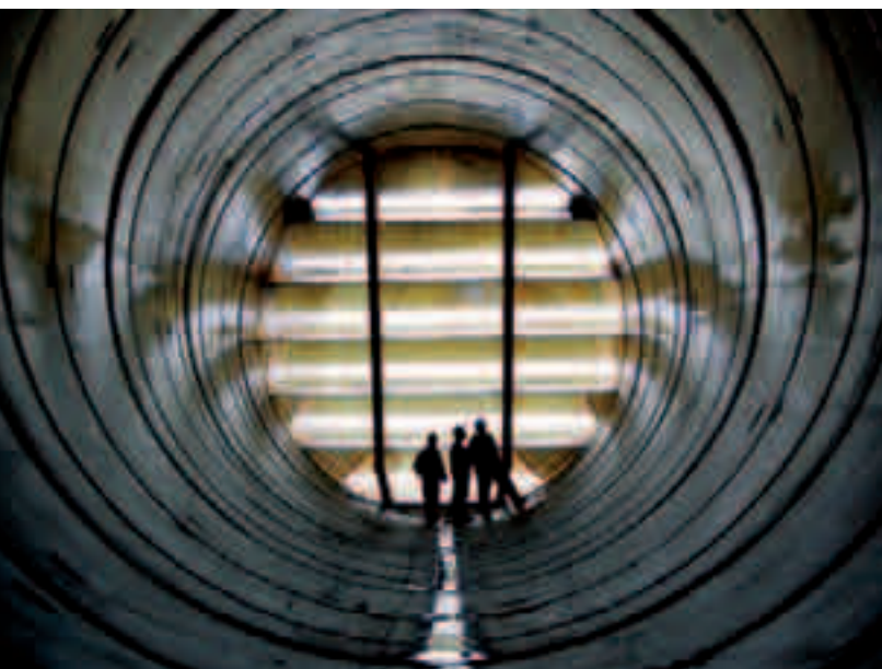
Überdimensionale Technik: Inspektion eines Rauchgas-Kanals.
