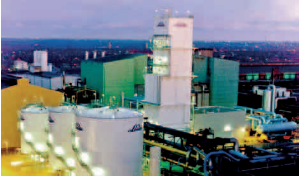
Zukunft ohne CO 2 : Linde-Luftzerlegungsanlagen, wie hier in Leuna, liefern Sauerstoff für viele Anwendungen, unter anderem für die saubere Stromerzeugung.
