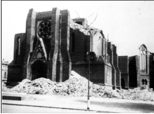
Полуразрушенное здание лютеранской церкви в Выборге в 1940 г. начали разбирать на стройматериалы, но разборку так и не успели закончить.
