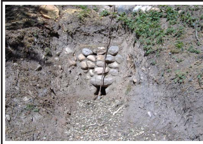
Desagüe exterior de una nevera.
