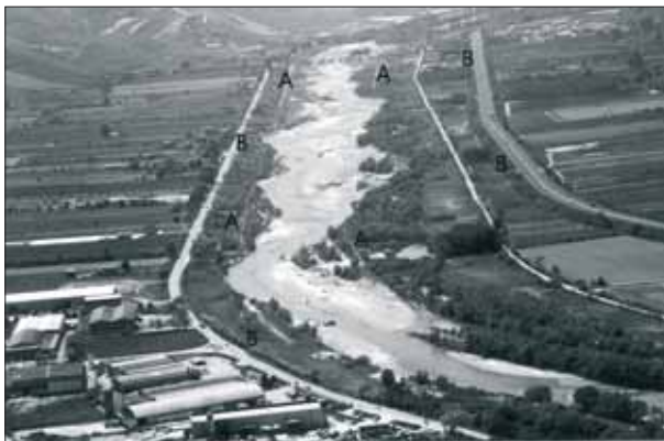
Fig.8 – Veduta della bassa valle del fiume Tronto due giorni dopo l'evento di piena dell'aprile 1992. In particolare si noti come gli argini artificiali del 1979 (A) siano stati erosi in più punti, mentre quelli già esistenti (B) siano integri.
