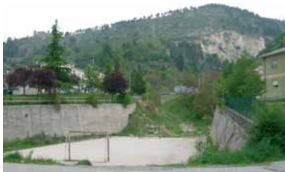
Fig.3 – Campo di calcio costruito nell'alveo di un torrente
