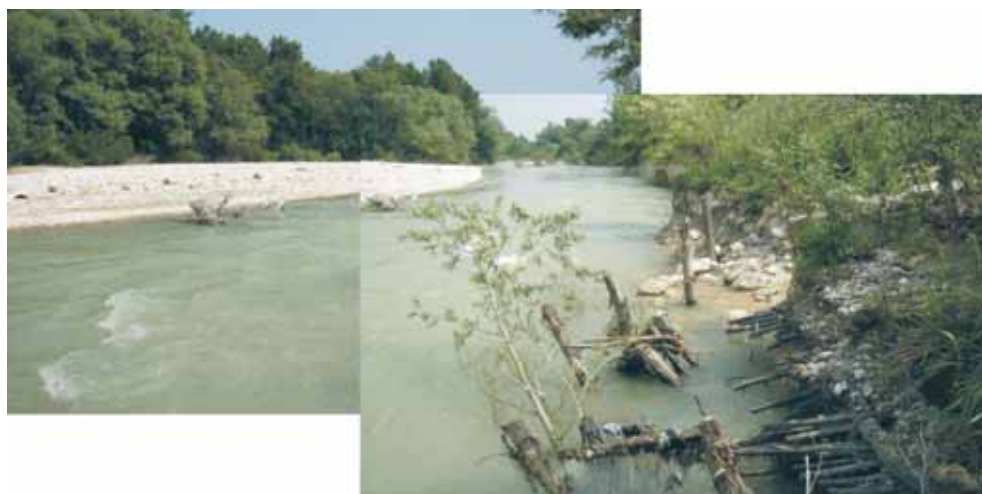
Fig.5 – Intervento di I.N. lungo il fiume Esino, completamente divelto.
