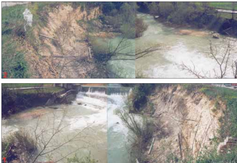
Fig.2 – Fenomeni franosi connessi con l'approfondimento dell'incisione in alveo, in un tratto del fiume Chienti (a Tolentino) con evidente allargamento della sezione fluviale.
