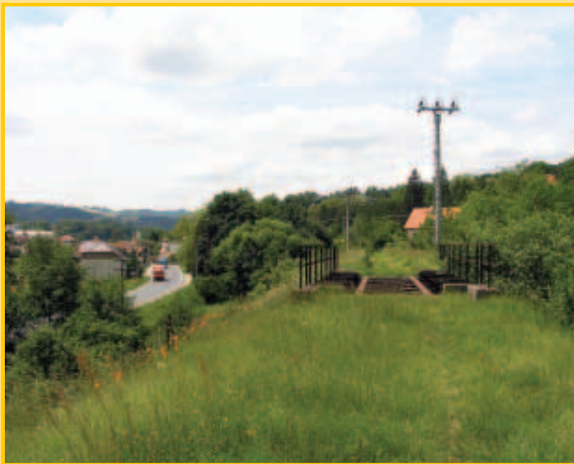
Železniční most na okraji Vizovic
