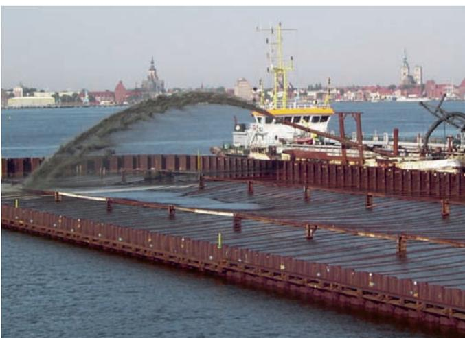
Abb. 20 und 21: Herstellung des Dammbauwerkes
