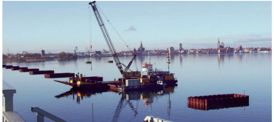
Abb. 6: Einsatz des Katamarans für Bohrpfeilarbeiten
