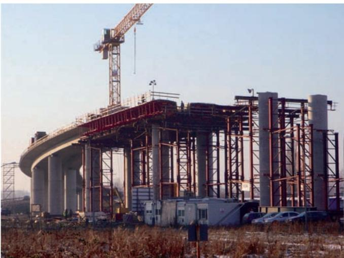
Abb. 11: Knotenherstellung der Y-Stützen mit SVB
