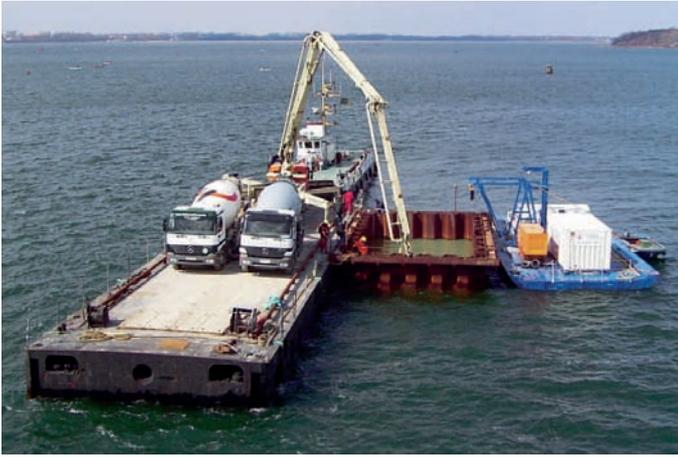
Abb. 7: Betonieren der Unterwasserbetonsohle
