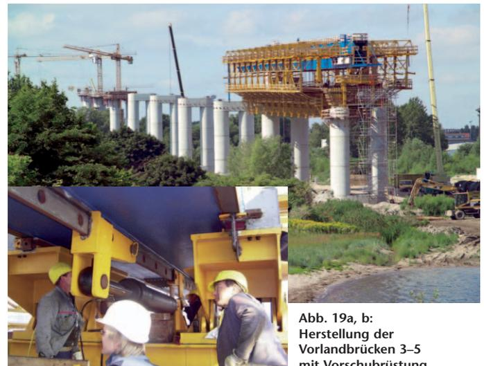
Abb. 19a, b: Herstellung der Vorlandbrücken 3-5 mit Vorschubrüstung
