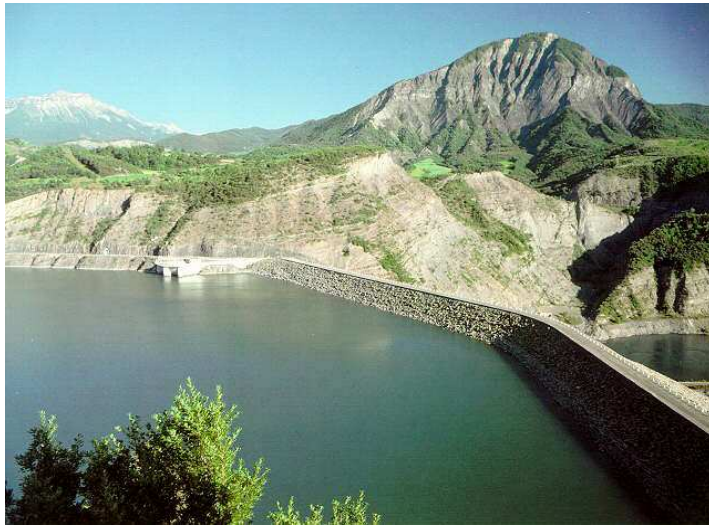
- Barrage de Serre-Ponçon – Barrage en remblai
