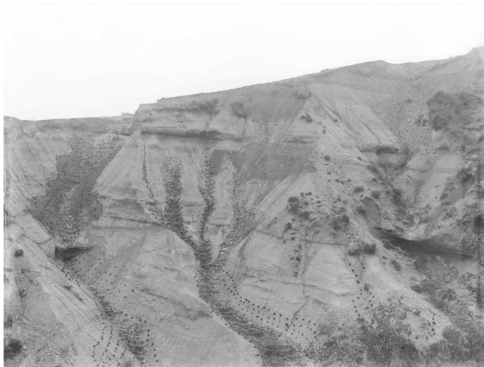
Garnissages exécutés en 1905 dans le ravin des Graves à Moustiers-Sainte-Marie
