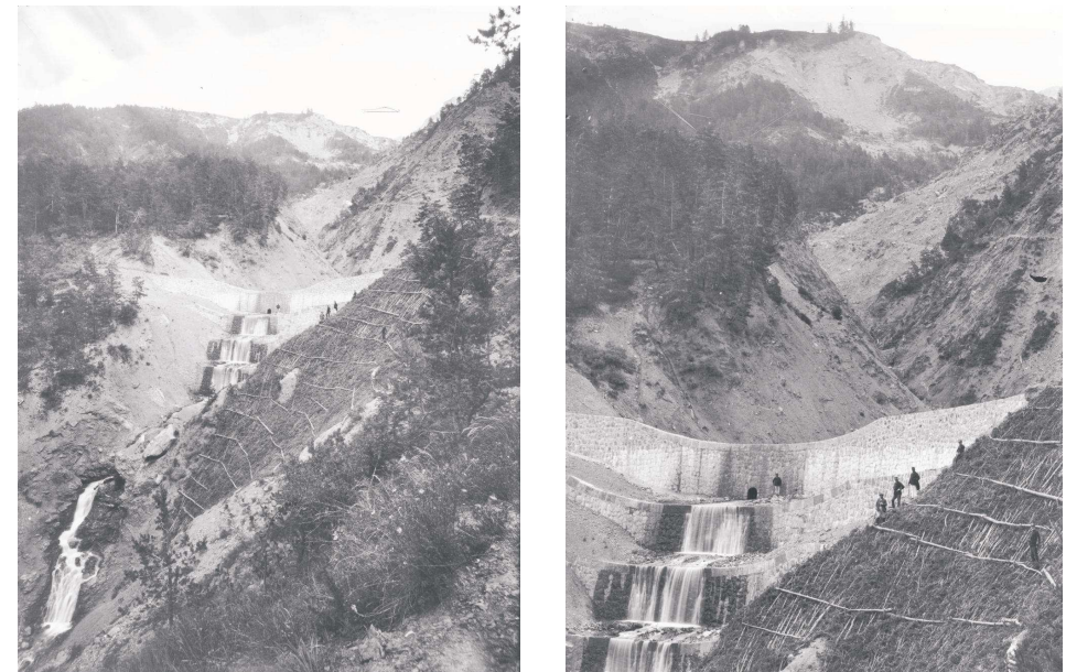
Groupe et détail de barrages de correction sur le torrent du Riou Chanal, à Uvernet-Fours – 29 juin 1895
