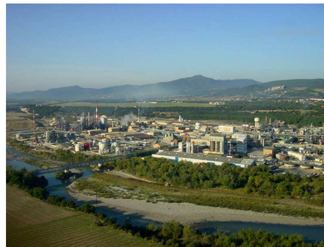
Site ARKEMA de Château-Arnoux-Saint-Auban
