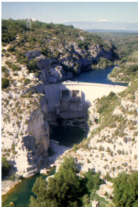
Barrage de Quinson – Barrage voûte
