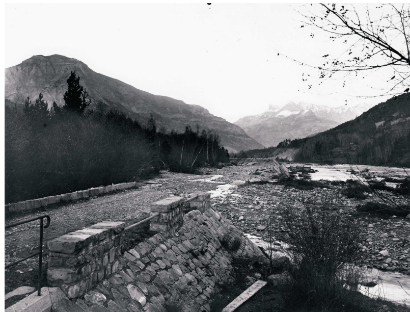
Crue du Verdon à Beauvezer – 1926
