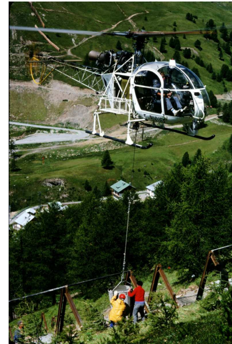
Construction de râteliers paravalanche à la Foux-d'Allos – août 1975
