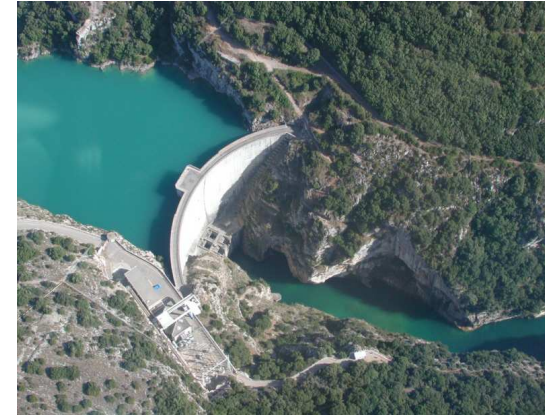
Barrage de Sainte-Croix – Barrage voûte
