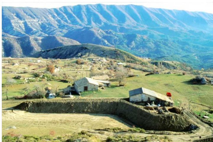
Digue en enrochement au Plat de Naux à Saint-Geniez – septembre 1997
