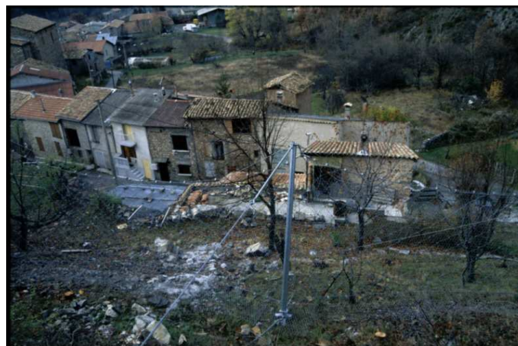
Filets pare-pierre au Caire – novembre 1997
