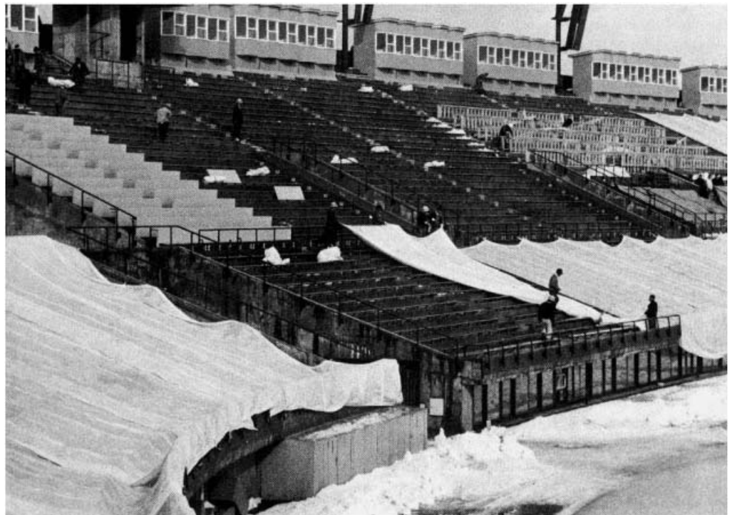
Protective covering spread over the stands at the Makomanai speed skating rink Couvertures mise en place sur les tribunes à la patinoire de vitesse de Makomanai
