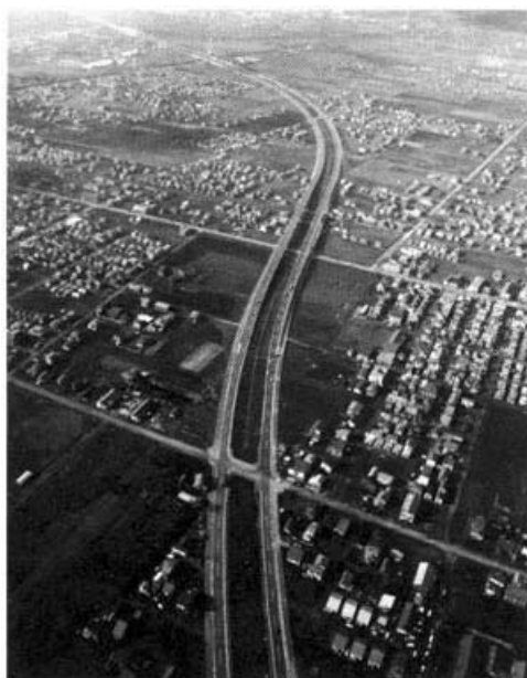
New Sapporo expressway Nouvelle auto-route de Sapporo
