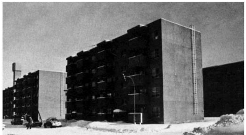
Makomanai Press House Maison de Presse à Makomanai
