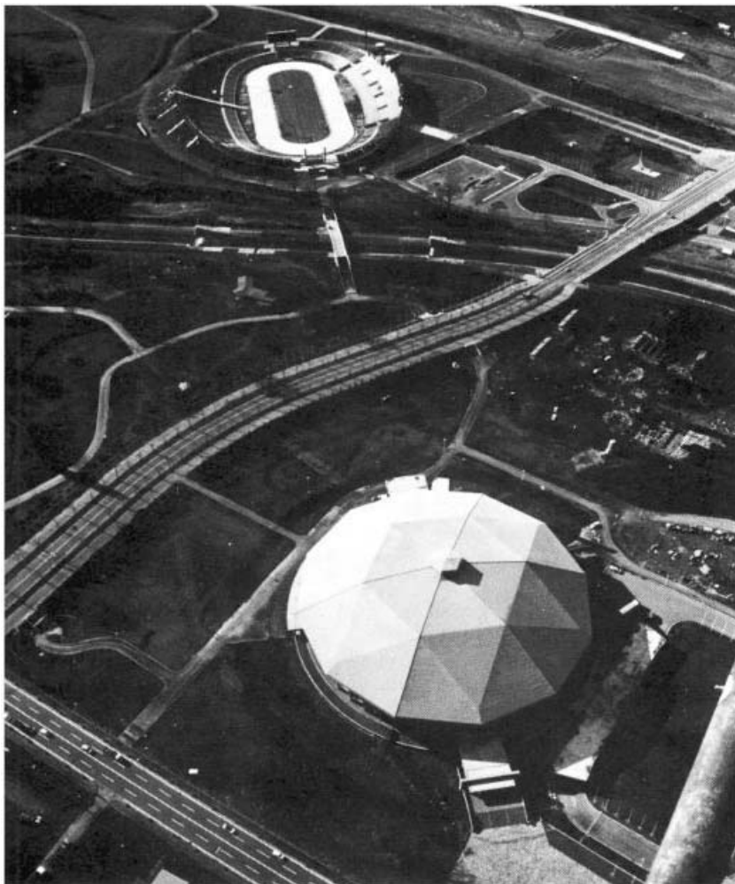
Makomanai indoor and speed skating rinks (built with Government funds) Patinoire couverte et patinoire de vitesse de Makomanai (construites avec les fonds Gouvernementaux)
