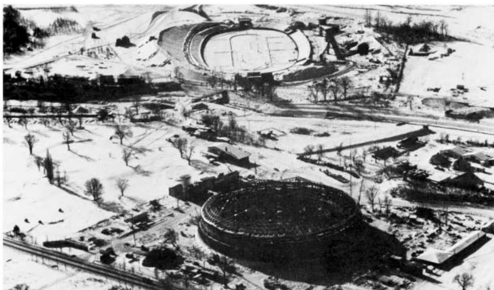
Makomanai indoor and speed skating rinks under construction Patinoire couverte et de patinoire de vitesse de Makomanai en construction
