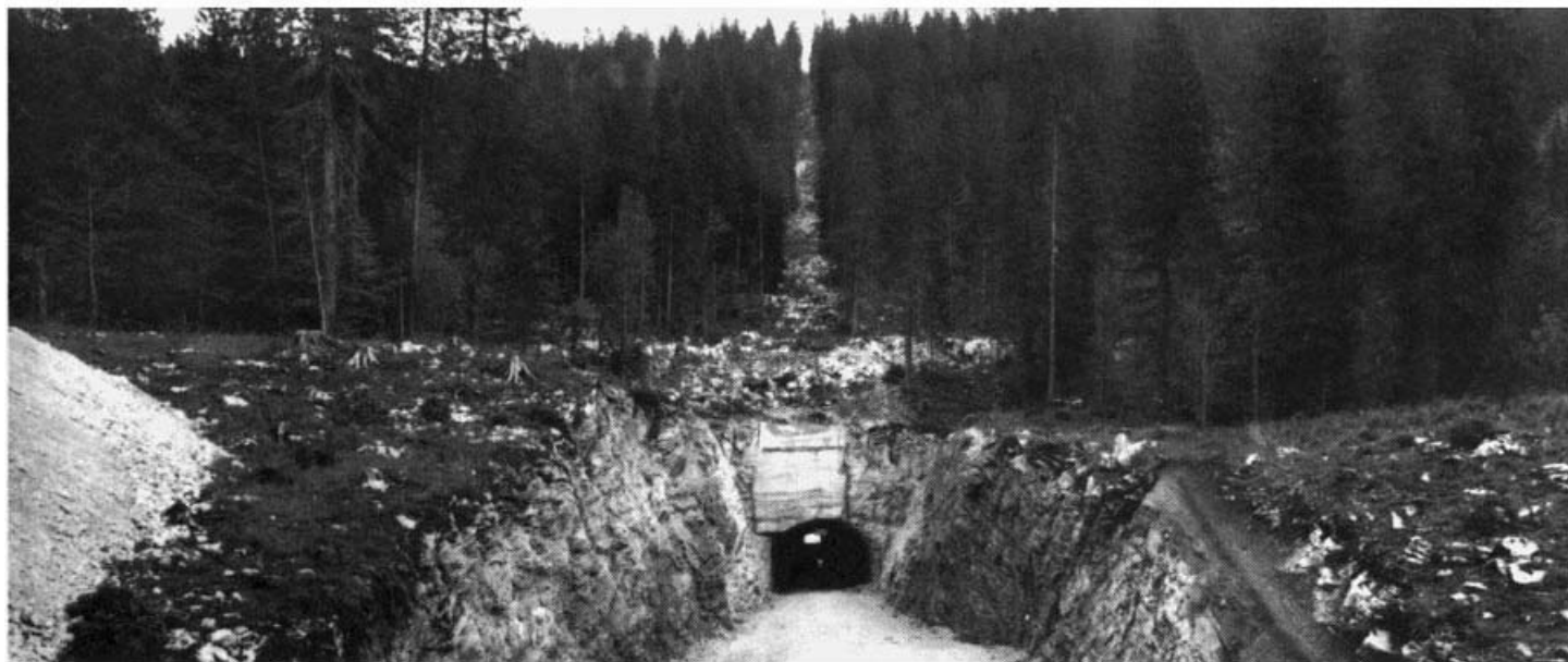
Le tunnel de Montaud dans le Vercors.
