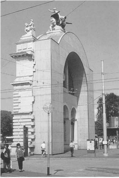
Abb. 8 Luzern, Bahnhofplatz, das Portal des alten Bahnhofs als Verkleidung der Lüftungsanlagen des Neubaus.
