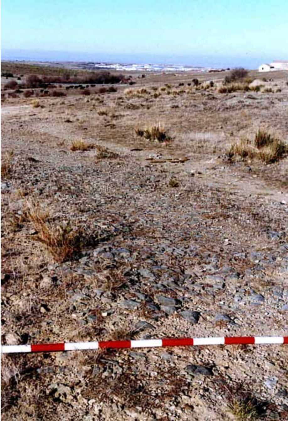
Ilustración 17: Pavimento de zahorra en el Camino de la Casona
