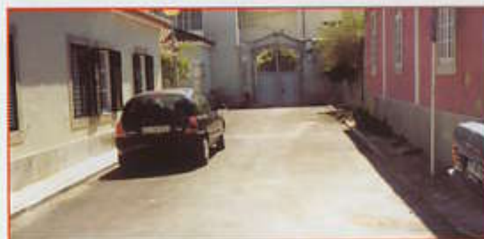
Afultamento do acesso à Casa de Saúde Sta. Rosa de Lima
