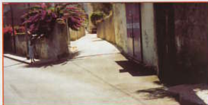
Calçamento da Travessa Conde Pombeiro.
