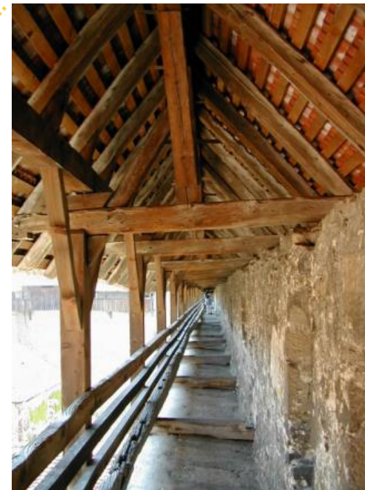
COURTINE NORD Couverture du chemin de ronde à l'époque bernoise
