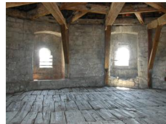
Baies-créneaux du dernier étage du donjon Plancher en demi-rondins grossièrement équarris
