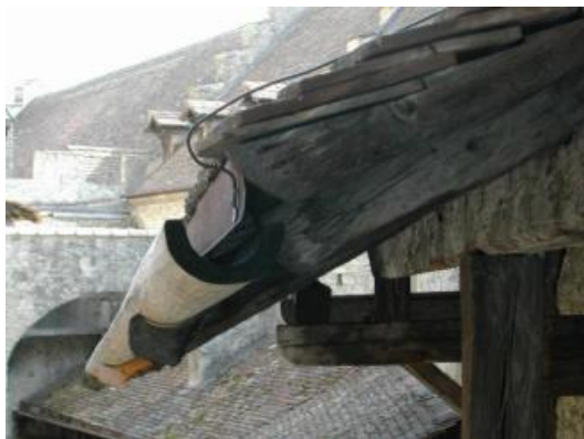
Détail d'un égout en bois
