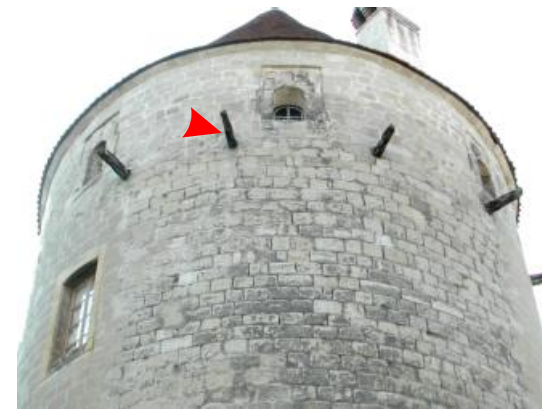
Poutres en bois attestant existence des hourds extérieurs à l'époque savoyarde
