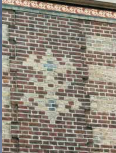
Sur les murs de l'ancienne mairie, les briques jaunes, rouges et bleues forment d'élégants motifs accompagnés de frises de carreaux de céramique.
