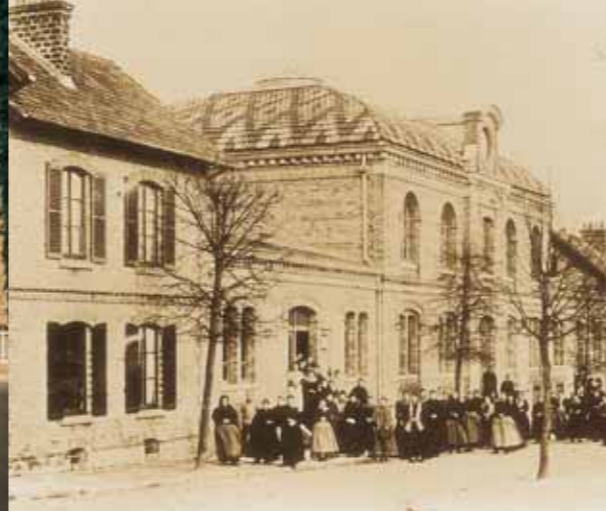
L'originalité de la toiture des anciens réfectoires tient dans sa forme rhomboïdale et dans les motifs géométriques dessinés par les tuiles polychromes.
