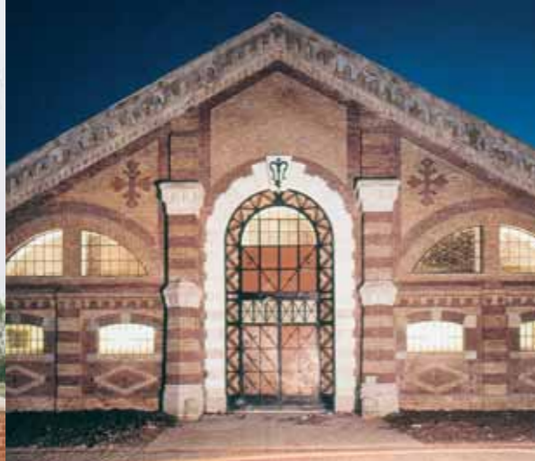
Aujourd'hui Théâtre labellisé Scène nationale, l'ancienne grange établie de la ferme du Buisson présente une architecture où la brique et le béton se côtoient harmonieusement.
