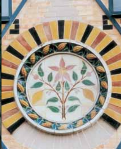
Sur la façade du moulin Saulnier, le cacao est à l'honneur, fleurs et cabosses se déclinent sous diverses formes. La restauration de cet édifice, classé au titre des monuments historiques, a rendu aux couleurs toutes leurs nuances et leur fraîcheur originelles.
