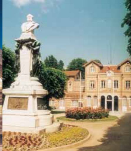
Aujourd'hui Hôtel de ville, les anciennes écoles, réhabilitées et agrandies en 1994, ont retrouvé leur façade d'origine, élégamment décorée de frises de carreaux de céramique et de briques colorées.
