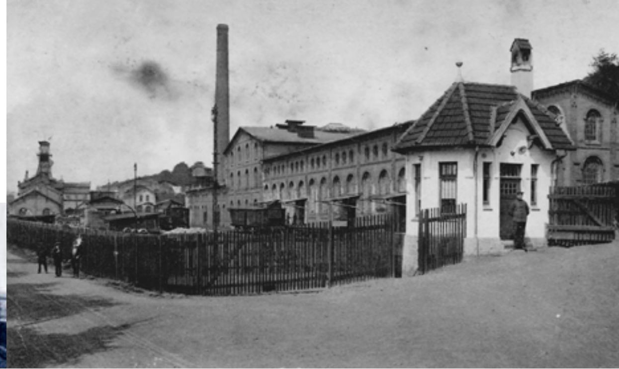
Die Gewerkschaft „Hercynia“ errichtete 1886 bei Vienenburg das erste Kalibergwerk außerhalb des Staßfurter Raums und gehörte zu den frühen Mitgliedern der Carnallit-Konvention.
