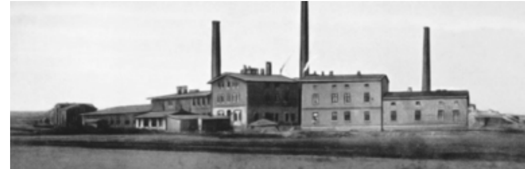
Kalifabrik der Firma „Zimmer & Co.“ bei Staßfurt im Jahr 1881. Das Unternehmen gehörte zu den ersten Produzenten von Kaliumchlorid.
