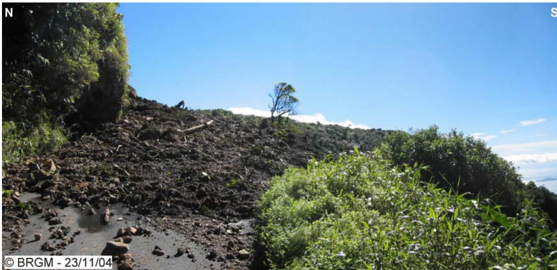
Figure 126 - RD11 : dépôts du glissement 2 sur la chaussée.
