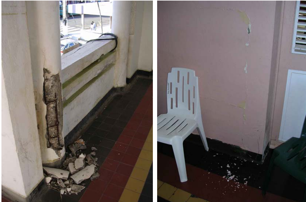
Figure 91 - Capesterre, mairie : éclatement du béton sur un poteau du 1 er étage et fissuration à la liaison poteau-remplissage.
