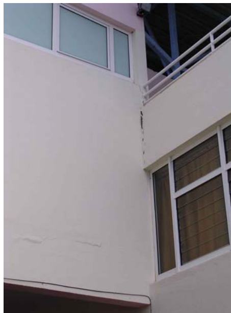
Figure 55 - Terre de Bas : fissures au collège de Petites Anses.
