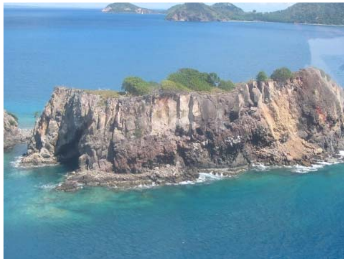
Figure 38 - Saintes, les Augustins : chutes de blocs sur la partie sud-est.
