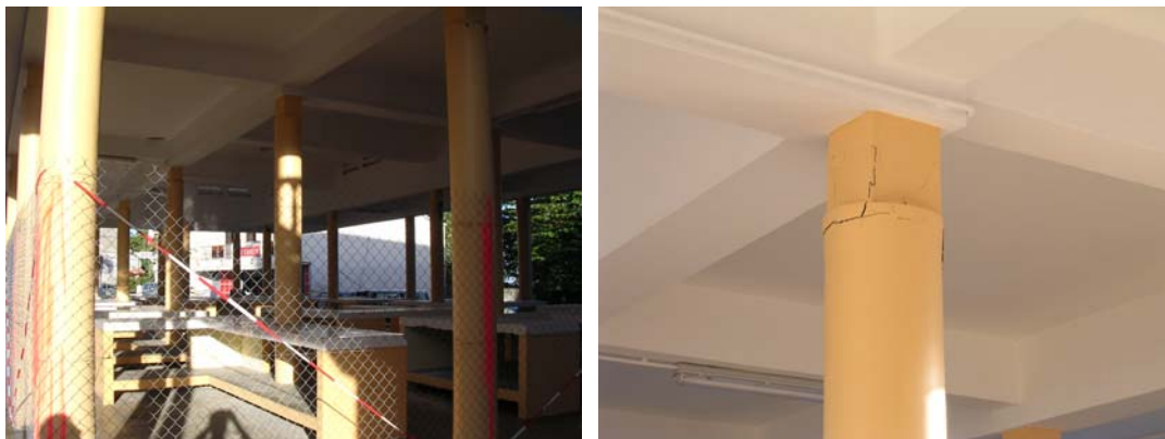
Figure 91 - Capesterre, mairie : éclatement du béton sur un poteau du 1 er étage et fissuration à la liaison poteau-remplissage.
