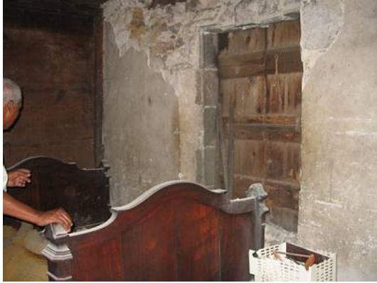
Figure 78 - Saint-Claude : maison en moellon au centre bourg. Chute de moellon sur le lit.
