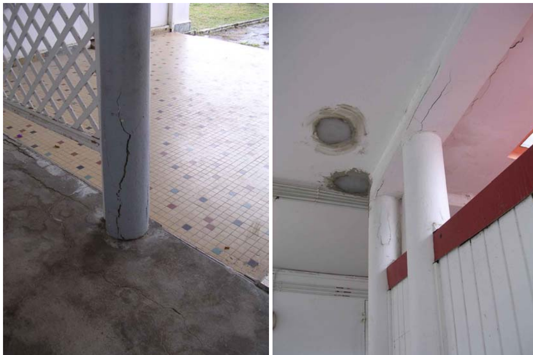
Figure 67 - Grand Bourg : exemple de dommages aux poteaux du bâtiment principal de l'ancien hôpital de Marie-Galante.
