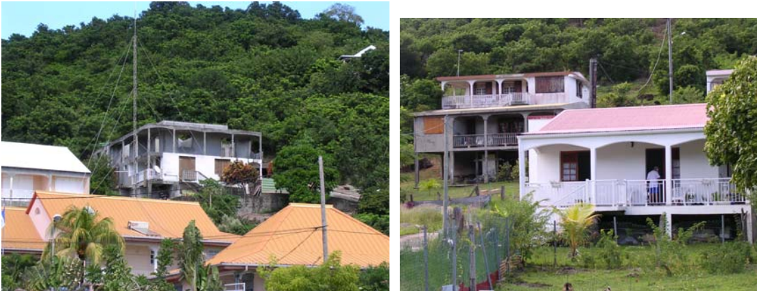
Figure 63 - Terre de Bas : deux maisons individuelles à proximité de la zone la plus affectée et qui n'ont subi aucun dégât apparent extérieurement.
