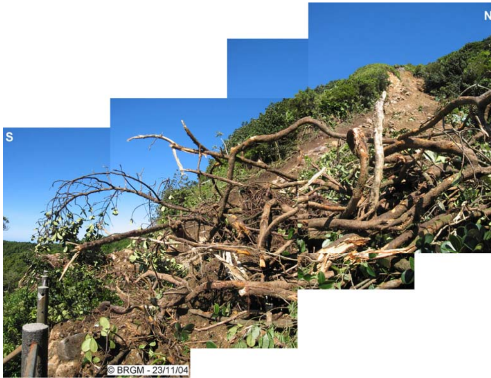
Figure 125 - RD11 : glissement 2, dépôts sur la chaussée, plan de rupture et barrière de sécurité de la route.
