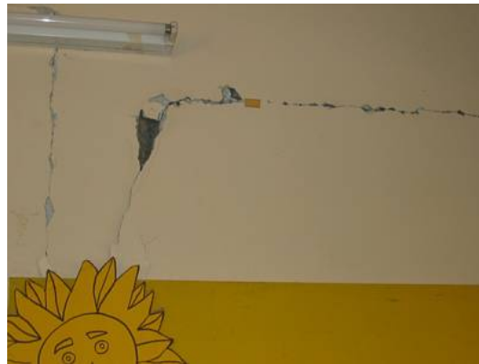
Figure 80 - Saint-Claude, école de Matouba : fissures en croix à l'entrée, sur le pourtour des cloisons à l'intérieur.
