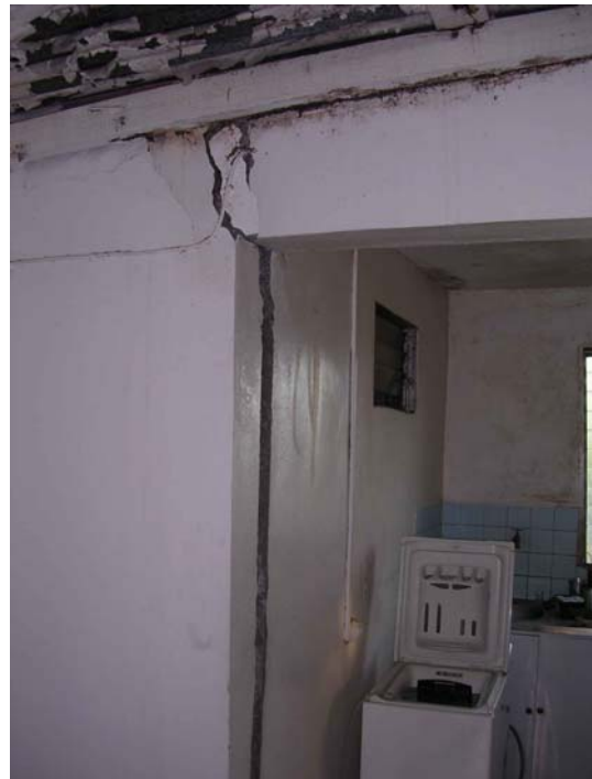
Figure 74 - Trois Rivières, lieu dit La Plaine. a) Dommages graves sur une maison individuelle. b) Désolidarisation d'un mur.
