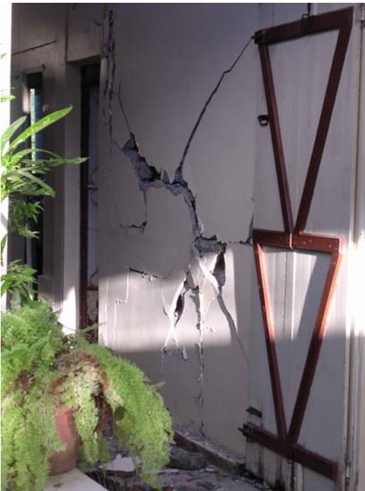
Figure 74 - Trois Rivières, lieu dit La Plaine. a) Dommages graves sur une maison individuelle. b) Désolidarisation d'un mur.
