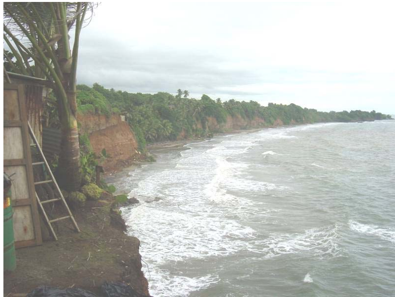
Figure 157 – Capesterre : maison en bordure de la falaise côtière effondrée.
