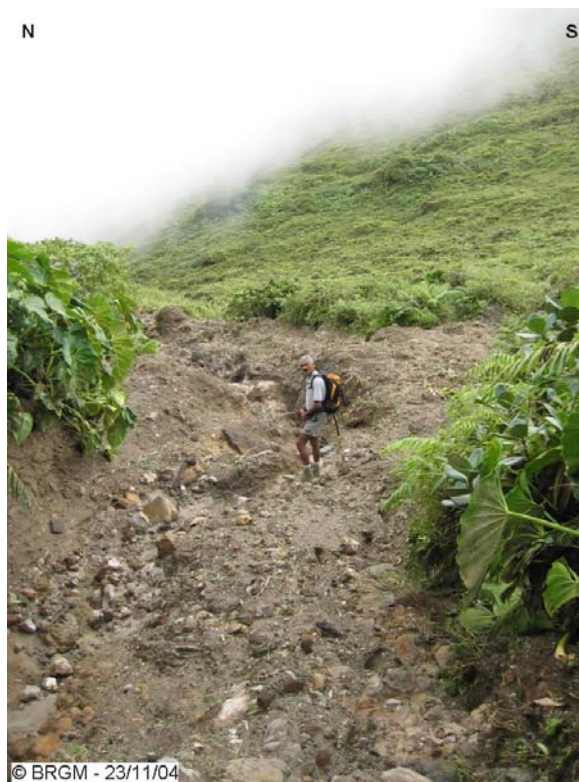
Figure 136 - Soufrière : glissement dans une ravine, ayant emporté le sentier.
