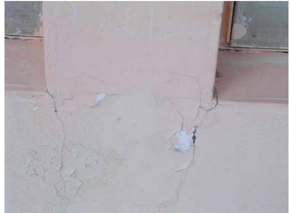
Figure 54 - Terre de Bas : fissures sur une maison à proximité du débarcadère.
