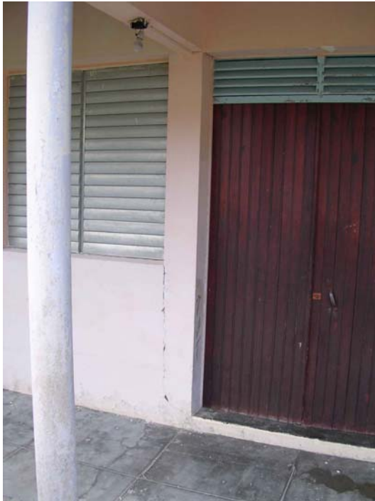
Figure 54 - Terre de Bas : fissures sur une maison à proximité du débarcadère.
