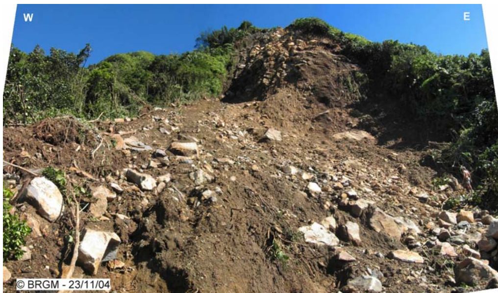
Figure 121 - RD11 : glissement 1 ; flanc SW du piton Tarade, vue amont.
