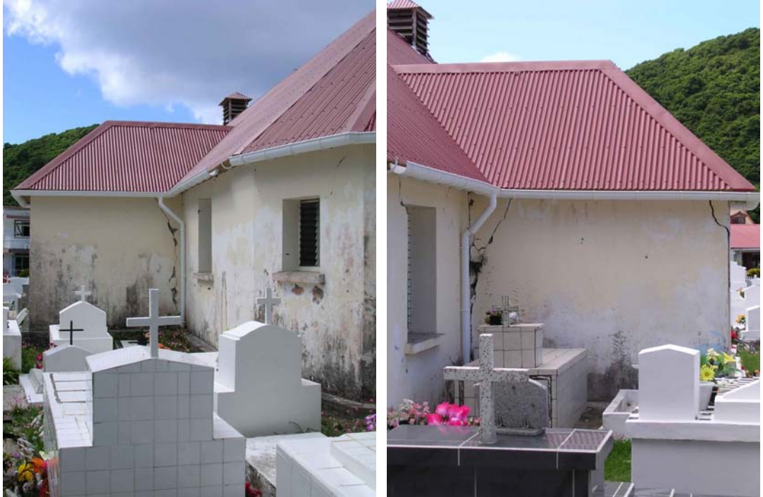
Les deux photos sont les vues de devant et de derrière de la même partie de l'église.
