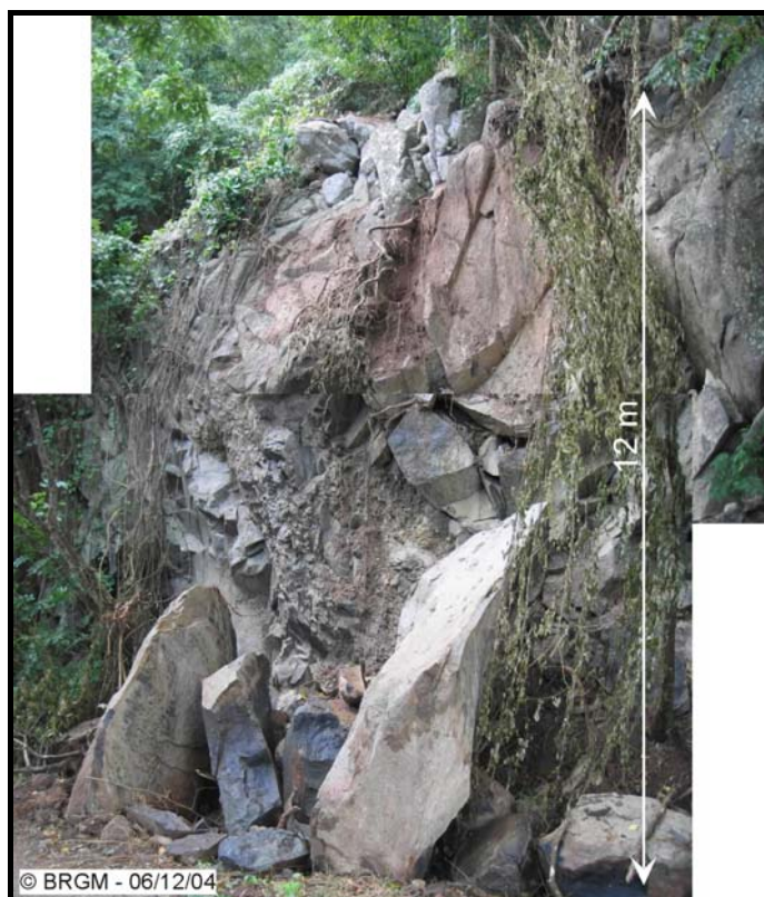
Figure 110 - RD 214 : partie occidentale de l'éboulement de la route du Chameau.
