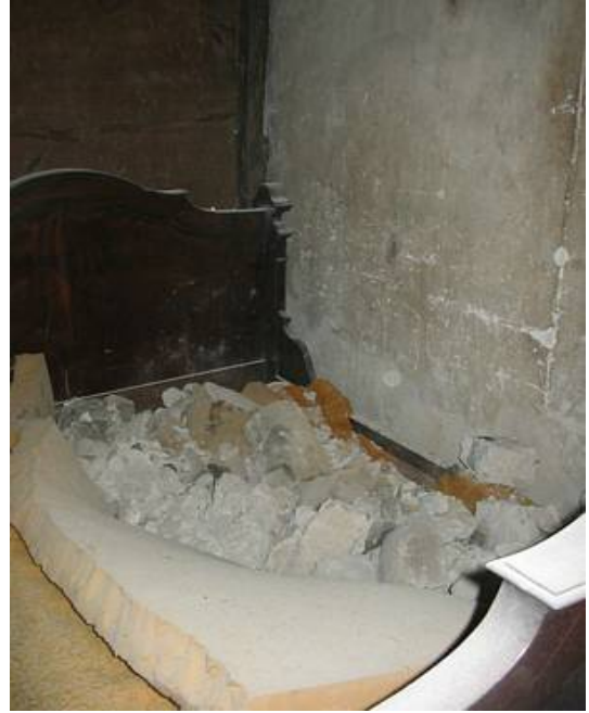
Figure 78 - Saint-Claude : maison en moellon au centre bourg. Chute de moellon sur le lit.
