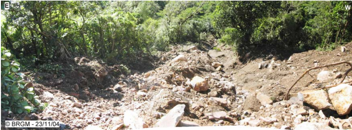
Figure 122 - RD11 : glissement 1, vue aval depuis la route supérieure. La coulée s'est propagée jusqu'au lacet en contrebas.
