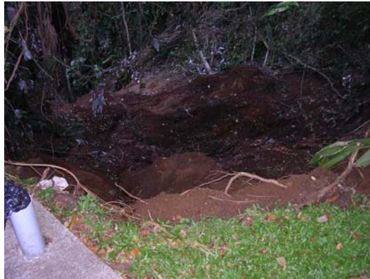
Figure 96 - Glissement de terrain dans le jardin d'une habitation et qui a emporté le barbecue.
