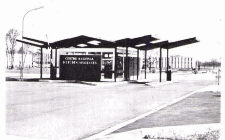
Poste de garde du Centre spatial de Toulouse (Cliché CNES).
