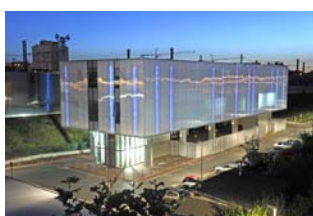
Poste de commandement centralisé L13 MALAKOFF
