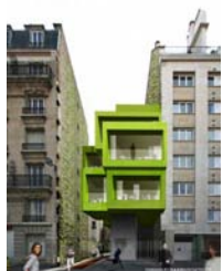
Poste de commandement centralisé L12 et Logements PARIS 15 ème
